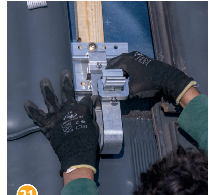
21 Einschnitt am Schaumstoffkeil um den Dachhaken...
