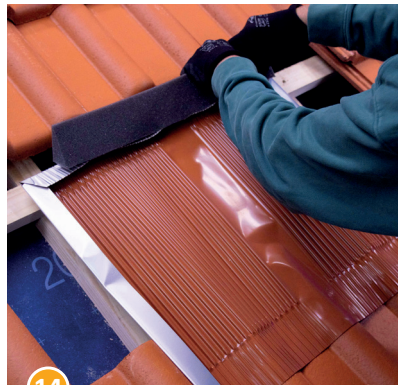
14 Schaumstoffkeil auf der hinteren Blechkantung der Beta-Platte festkleben.
