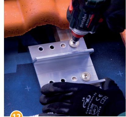
12 Fuß mit mind. 2 Holzschrauben (mind. 1 Stück pro horizontale Lochreihe, 10 Nm) am Dachsparren befestigen.
