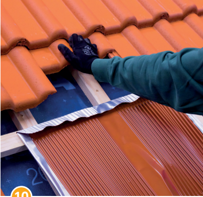
10 Dacheindeckung über Beta-Platte aufdecken.
