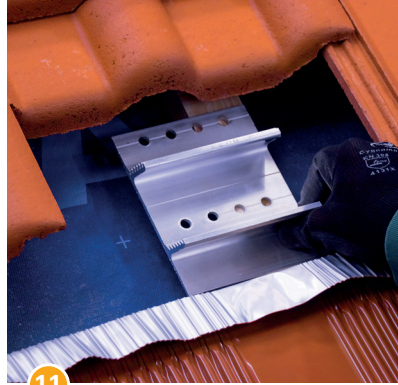
11 Fuß des Dachhakens auf dem Dachsparren ausrichten.
